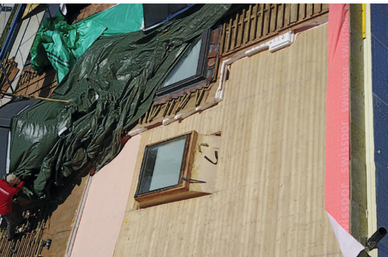
La toiture démontée jusqu'au lambris et en cours de rénovation
