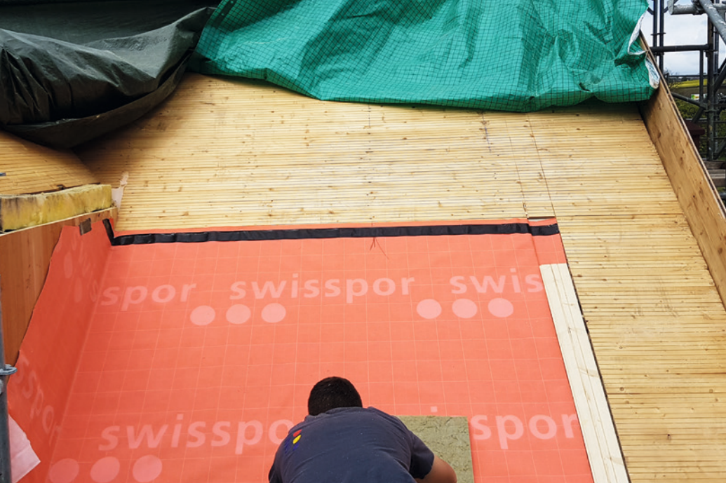
Pose du pare-vapeur
