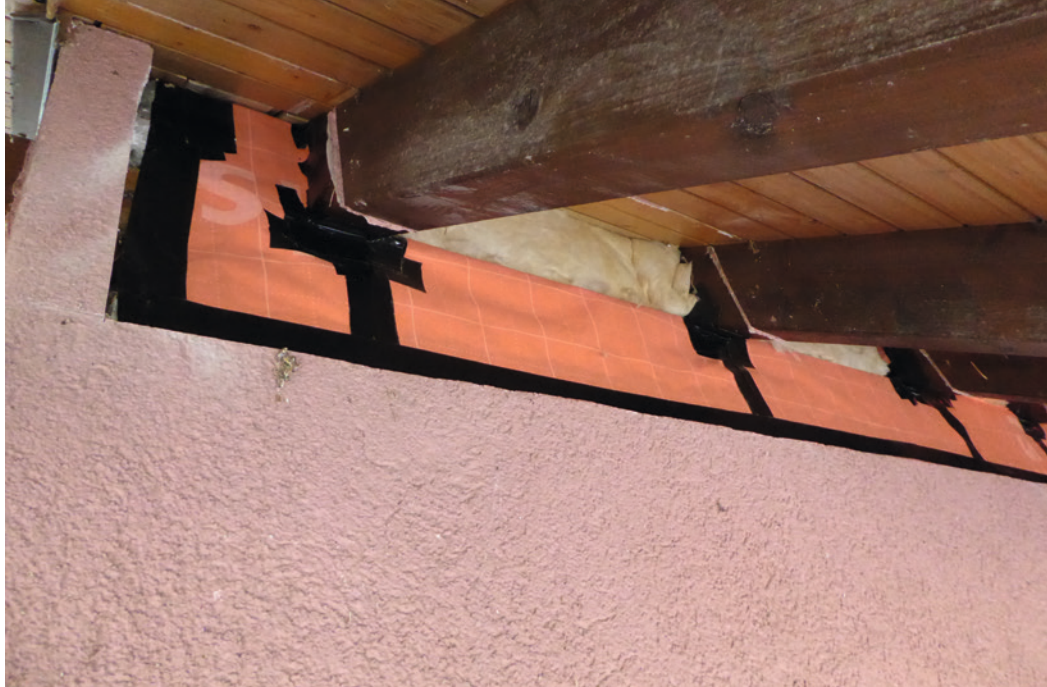
Le raccord du pare-vapeur sous l'isolation du mur gouttereau
