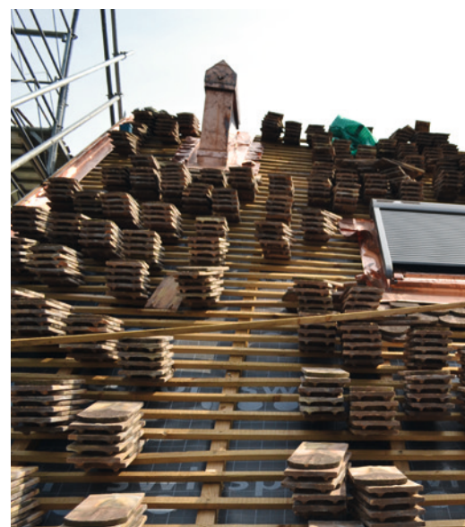
Pose de la couverture (tuiles plates récupérées)
