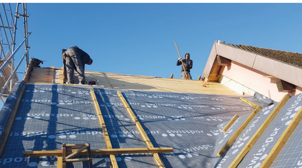
Pose du lattage sur la sous-couverture soudée pour une étanchéité parfaite
