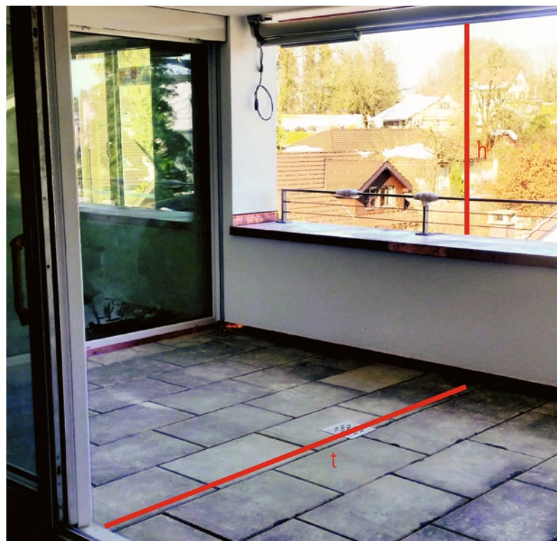
Fig. 3b: Ici, un caniveau est superflu car t est supérieur à h .
