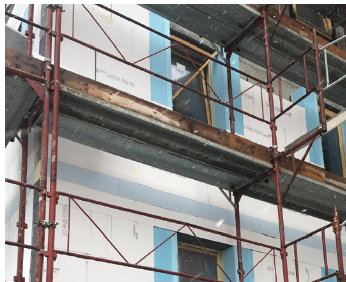
Le bâtiment est isolé sur ces faces (O et N) avec du swissporLAMBDA White 031.
