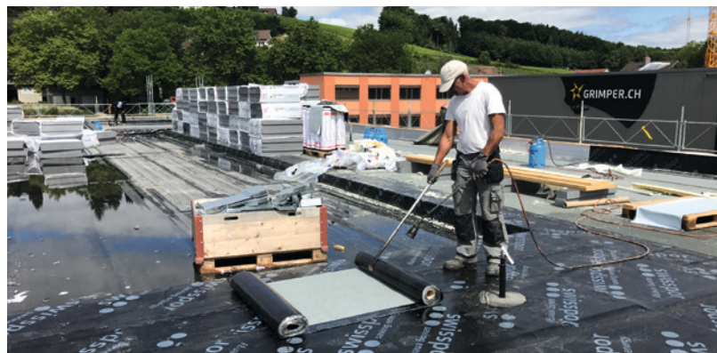
Pose de la couche supérieure du système d'étanchéité
